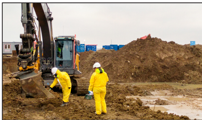
Löpande under perioden av schaktarbete har varje delområde slutprovtagits. Överlag visar resultaten på halter långt under mätbara åtgärds mål.
