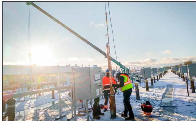
Värme spiraler lyfts på plats i 235 borrade hål. Med hjälp av växlande magnetfält kommer dessa spiraler att värma jorden till 300 grader.
